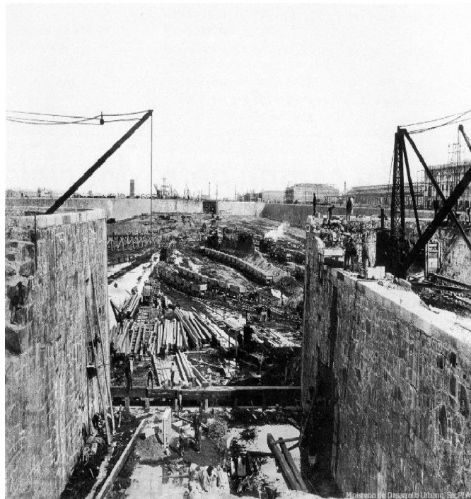
Fig 3. Construcción de Puerto Madero. Foto Pedro Repetto.
