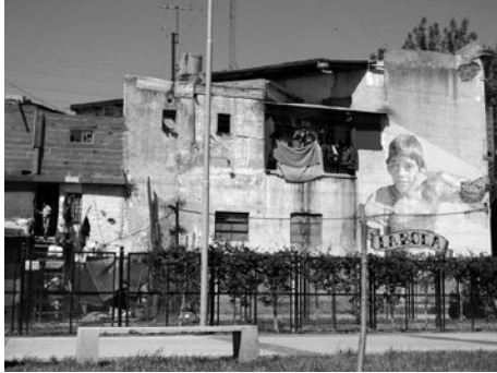
Viviendas precarias junto a nuevo enrejado.
