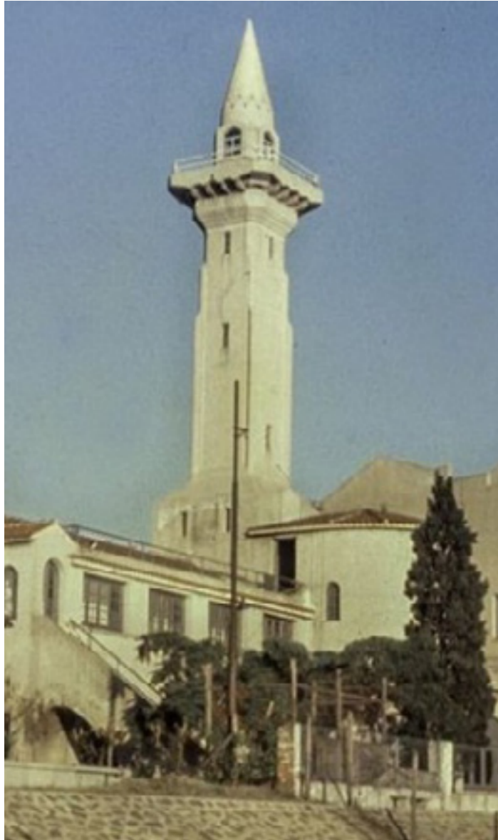
Figura 7. Torre de la Sede del Montevideo Rowing Club
