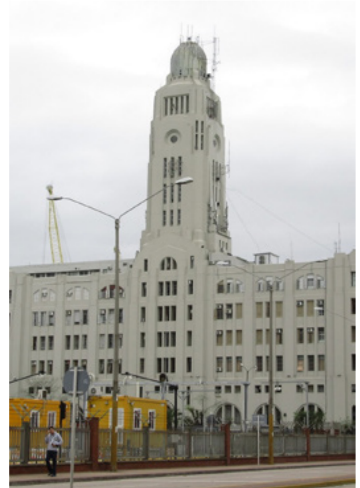
Figura 10. Edificio de la Aduana de Montevideo.
