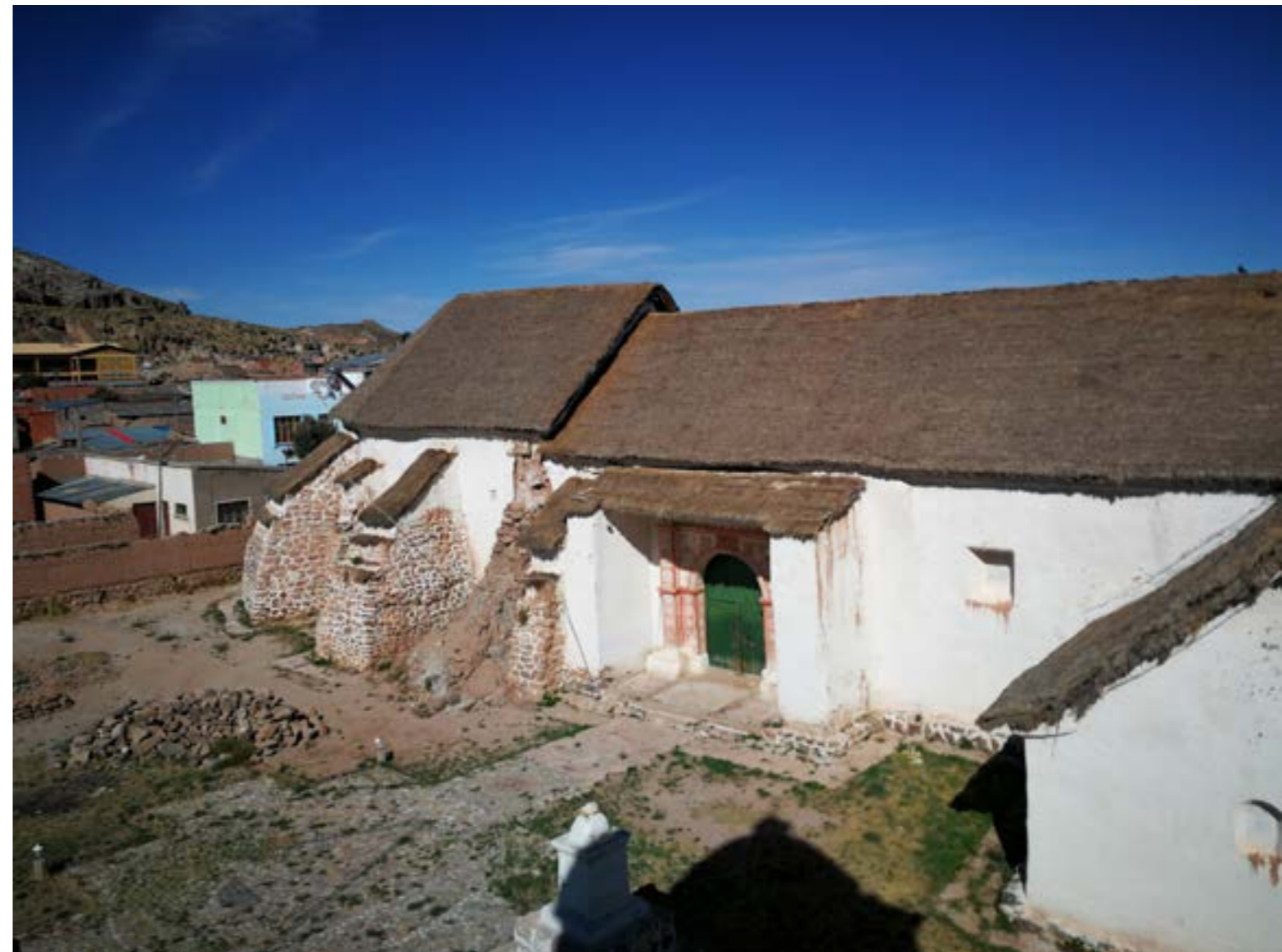
Figura 1. Vista de la iglesia Santiago de Curahuara de Carangas
