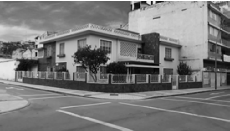
Figura 11: Perspectiva fotográfica 01 de la residencia Valdivieso.
