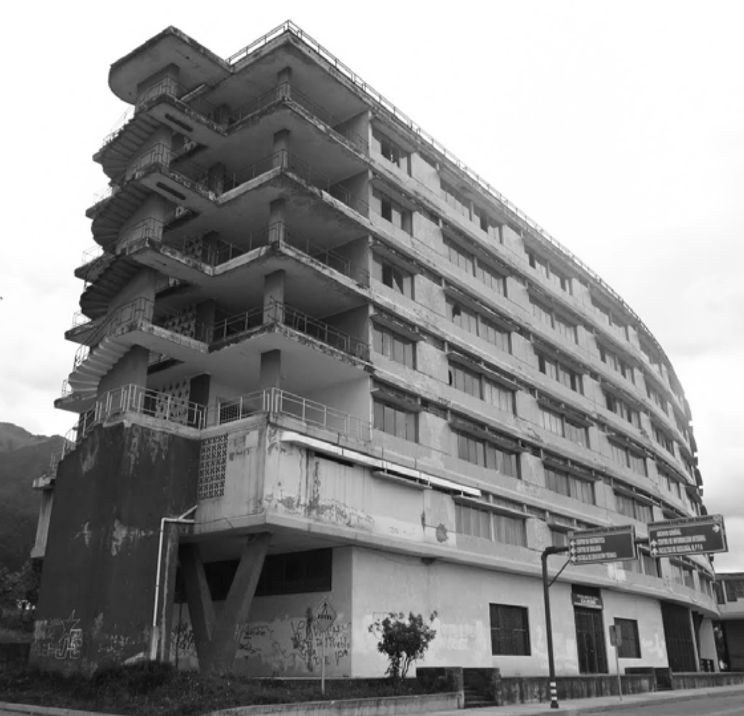
Figura 8: Residencia universitaria construida por Gilberto Gatto Sobral.
