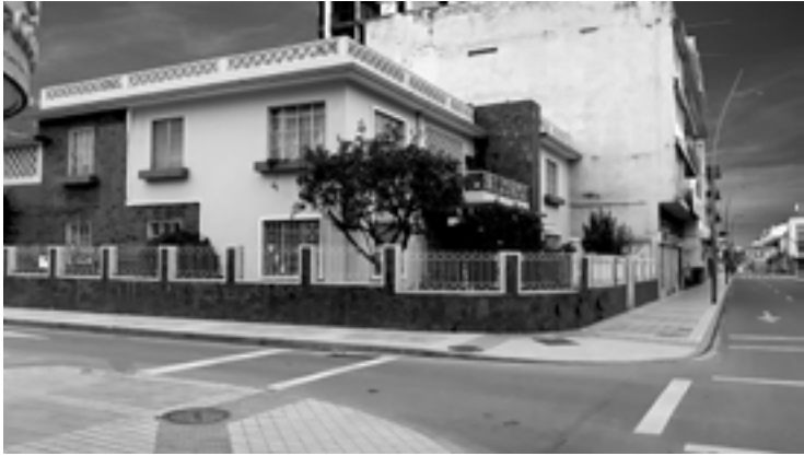
Figura 12: Perspectiva fotográfica 02 de la residencia Valdivieso.
